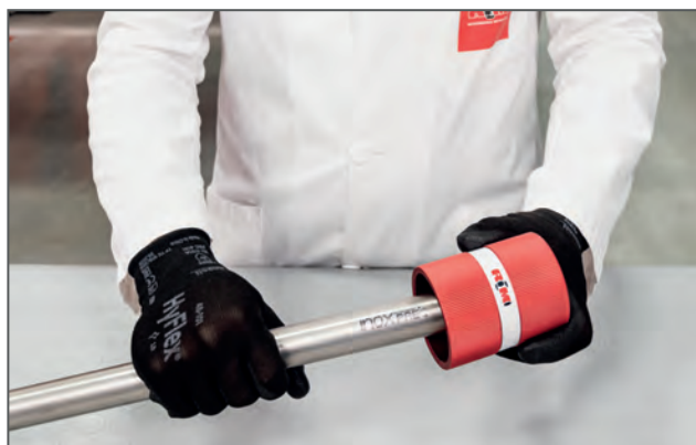
Sbavatura del tubo / Deburring the pipe
