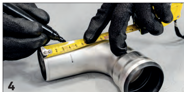
Marcatura quota d'innesto / Marking the insertion's depth
